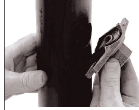
3. Conta montajı Gasket installation
