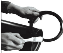
2. Contayı yağlayın Lubricate gasket
