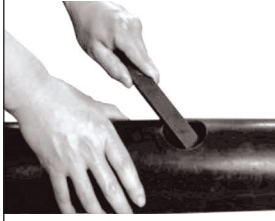
2. Çapakları temizleyin Remove burrs
