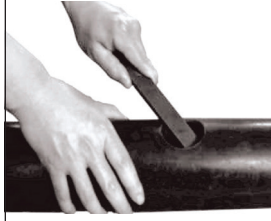
2. Çapakları temizleyin Remove burrs
