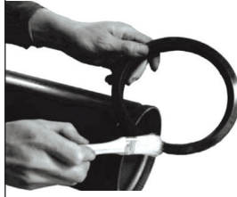
2. Contayı yağlayın Lubricate gasket
